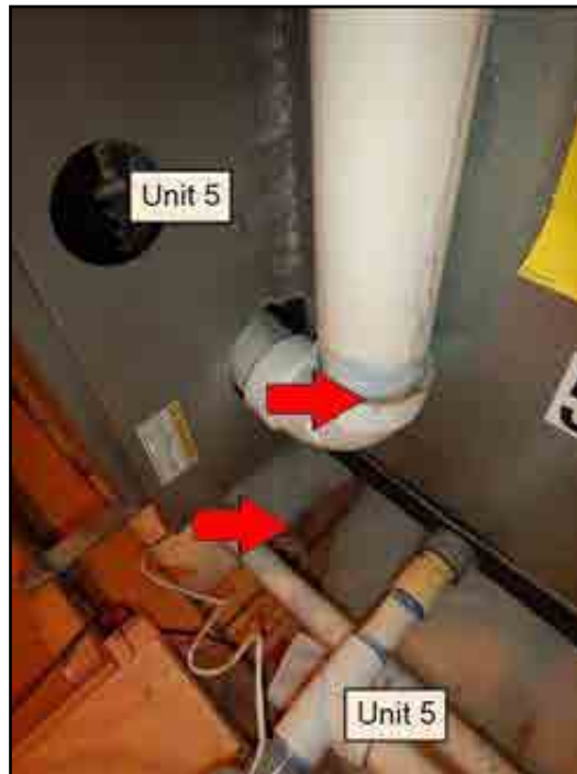
161. Condensate leak
